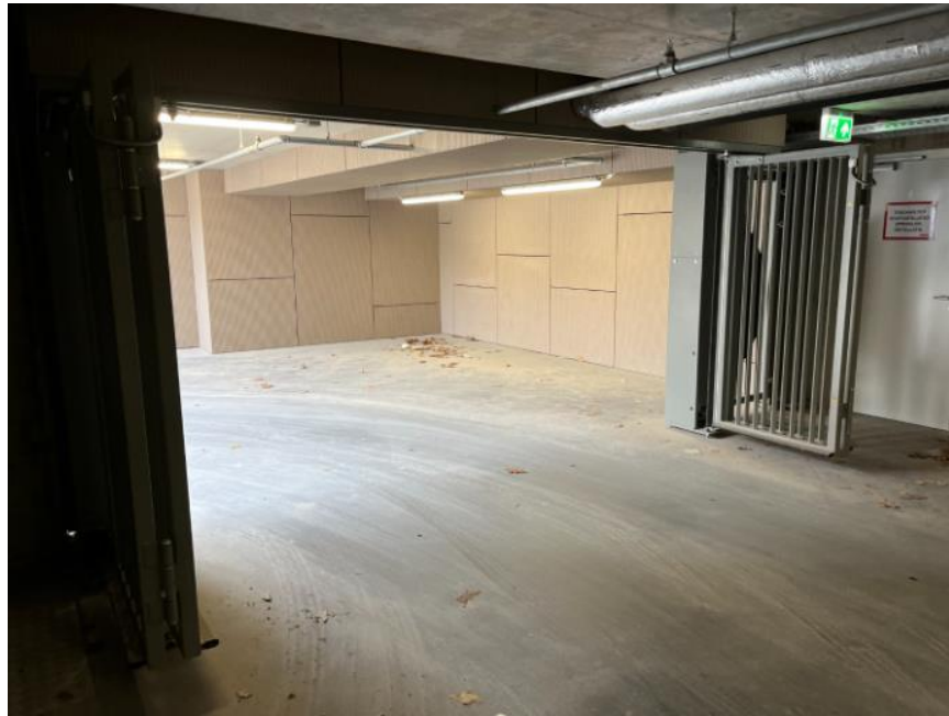
Hellingbaan naar parkeergarage
