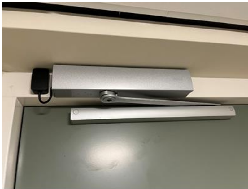
Voorbeeld van een vrijloopdranger gemonteerd op een deur
