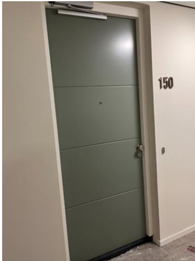
Deur sluit automatisch bij brandmelding of stroomuitval
